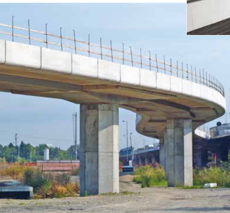
9. Il viadotto Rampa D in corso lavori
