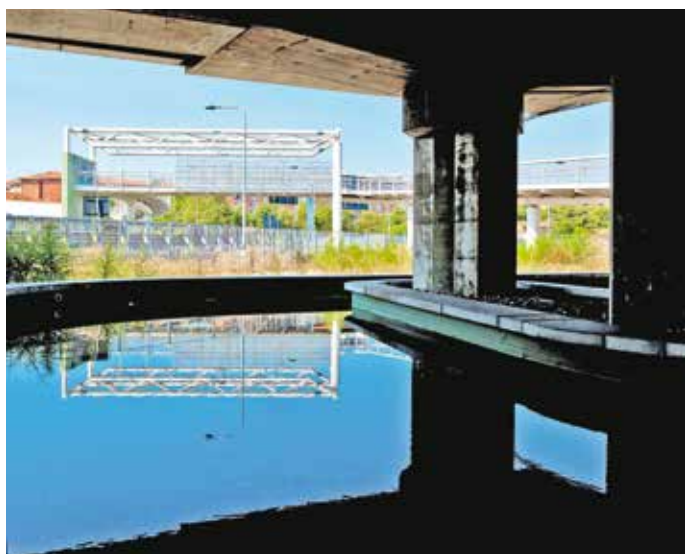
25. L'area laghetto con vista dell'attraversamento della rampa F
