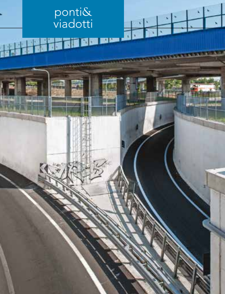
16. Un dettaglio dell'affiancamento delle Rampe A e B
