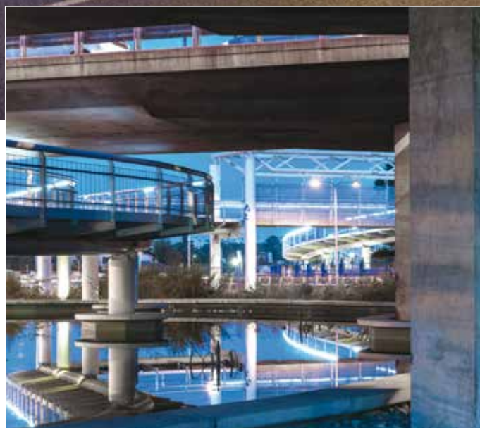
24. L'area laghetto sotto il viadotto dei Parchi
