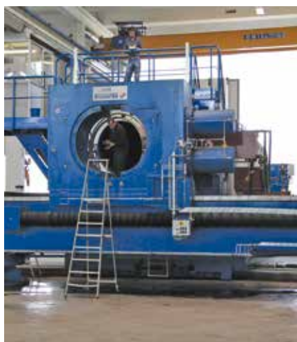
26. La calandratura della struttura tubolare della passerella
