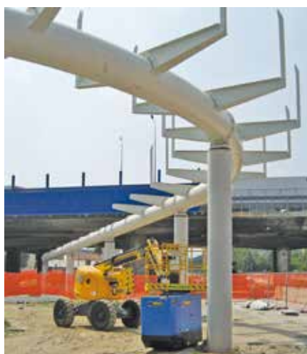
27. Il montaggio delle strutture principali della passerella
