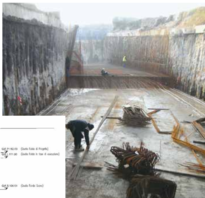
13. Le fasi di costruzione della Rampa A
