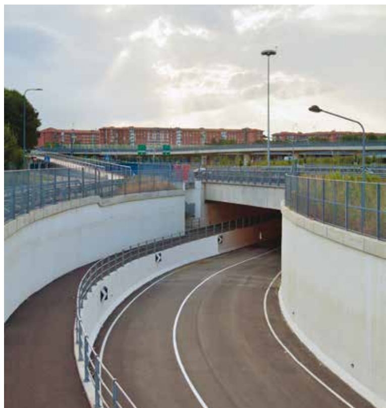
15. L'imbocco della galleria di Via Canelli
