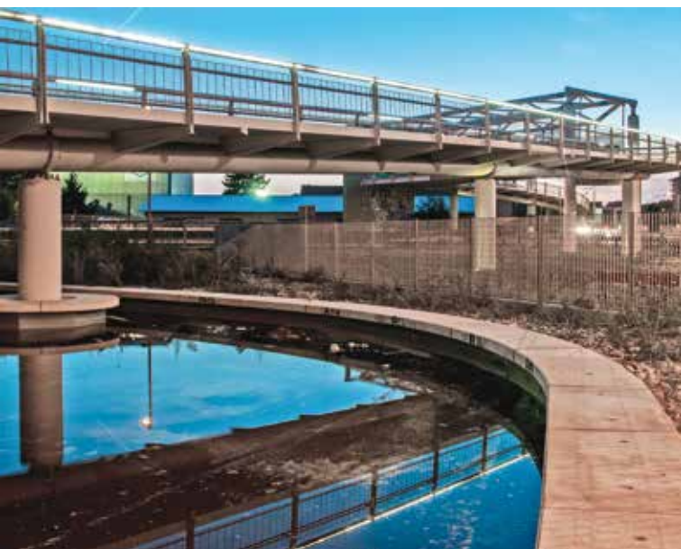
23. L'area laghetto in prossimità dell'attraversamento della rampa F
