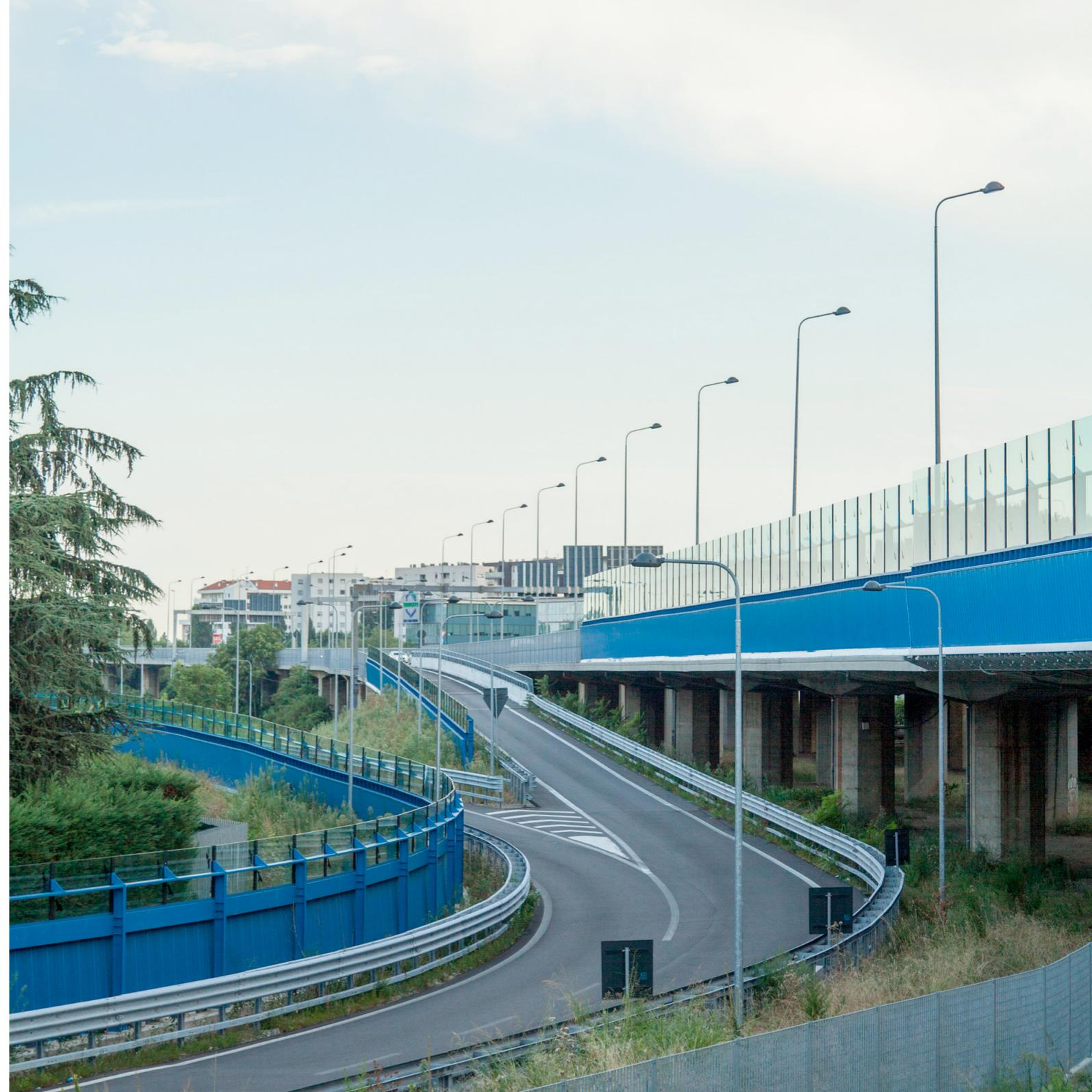
Per le rampe, dal punto di vista dei tracciati stradali, le pendenze massime longitudinali assunte si mantengono tra il 4,2% e il 7%, mentre la pendenza trasversale corrente è pari al 2,50% verso l'esterno della curva.
